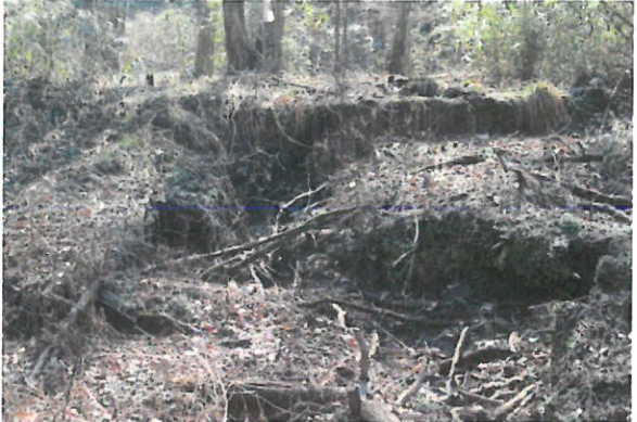
<池の上流側、土砂の崩落・流入>
