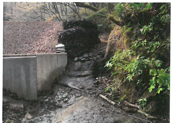
落差が減り、人工的な護岸
