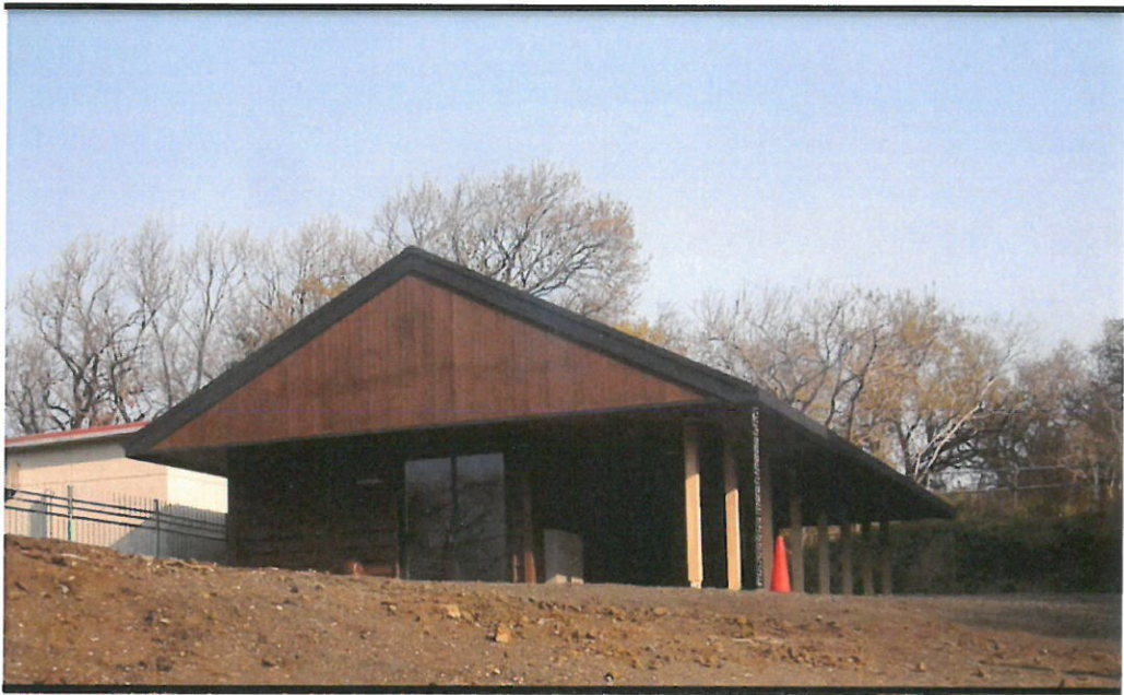
<建設が進む管理用施設 山ノ内配水池脇>
