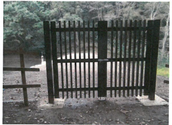
入口に扉。堤体上にはまだ植生がない
