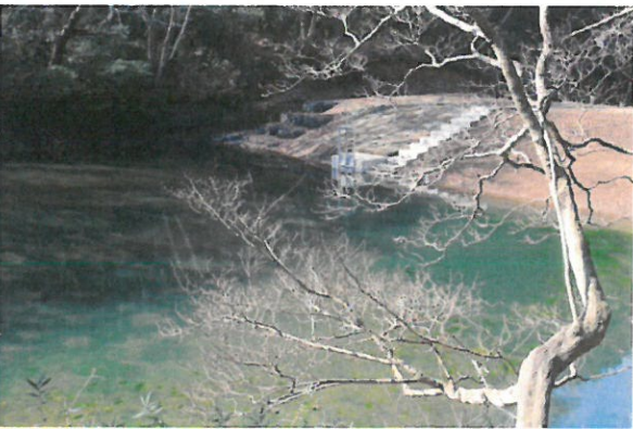
<池と堤防、水門>
