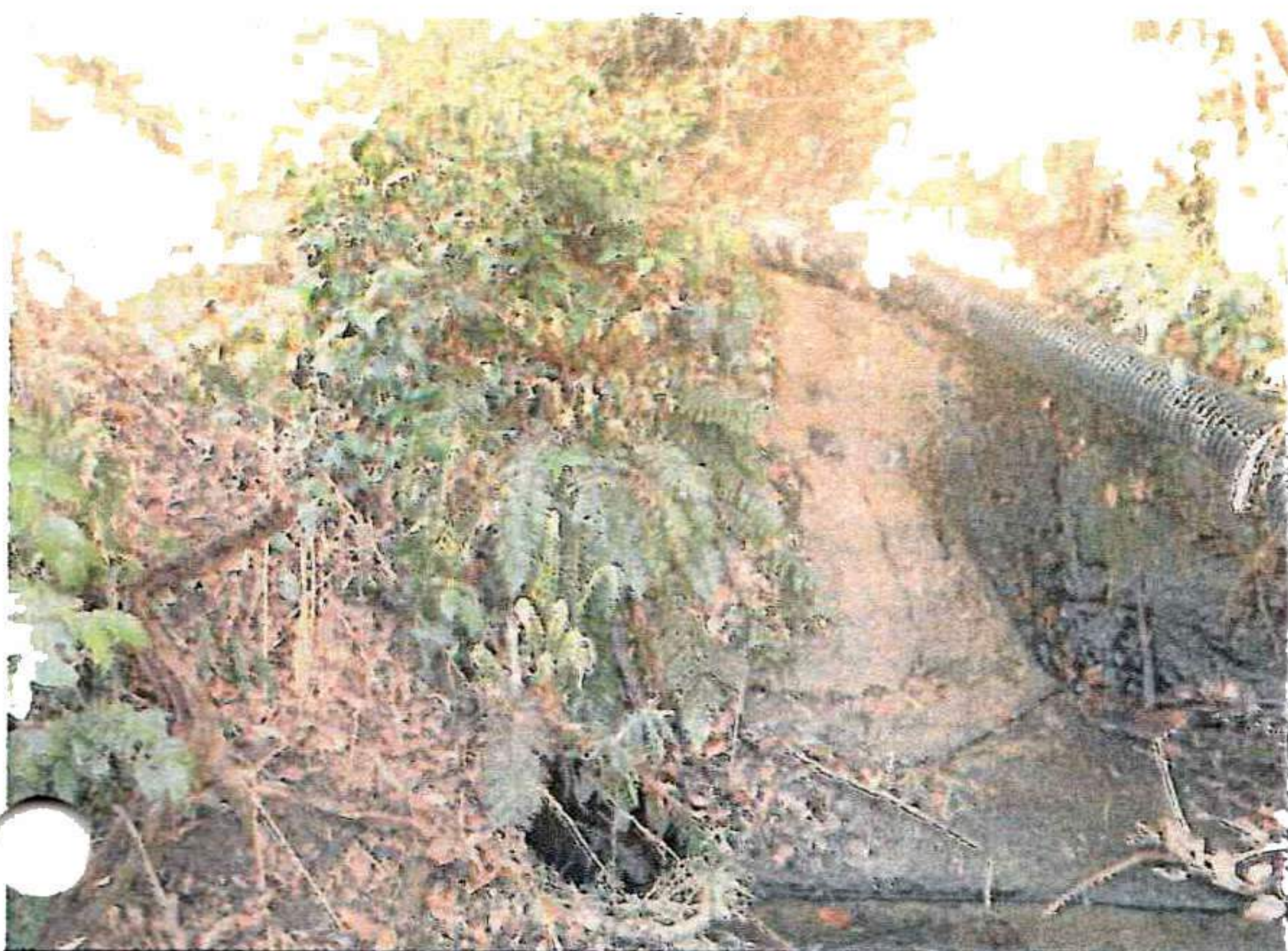
改修される堤防の落ち口 水抜きできる排水管と水門が設置される
