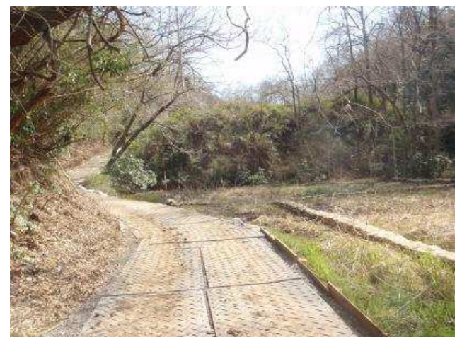
<残ることになった仮設路、幅を狭くし土を被せる>
