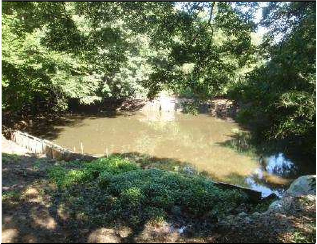
＜浚渫が終わり、水位が下がった谷戸の池＞
