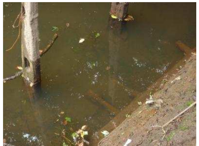
<水位が下がり昔の排水溝が見えてきた>
