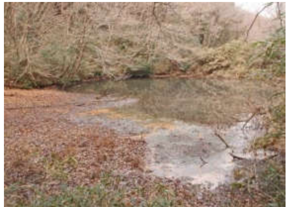
ヘドロの浚渫が必要になってきた「谷戸の池」 農業用の溜め池として利用されなくなってから、 ほぼ半世紀、ヘドロの浚渫が必要になってきている。 この工事のため、仮設路の建設が必要になる。
