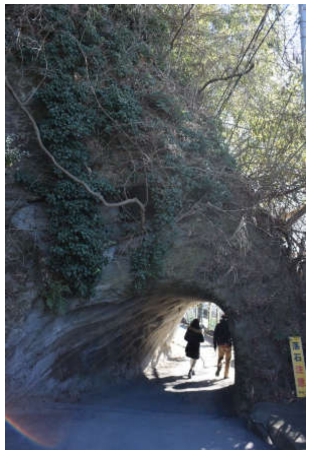
<北側から見た岩塊と洞門。右下に「落石注意」とある>
